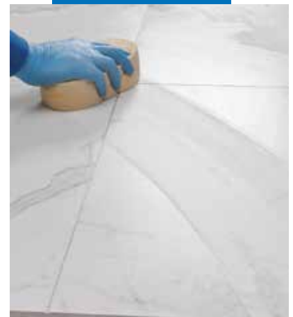
Pulizia e finitura delle fughe con spugna di cellulosa dura
