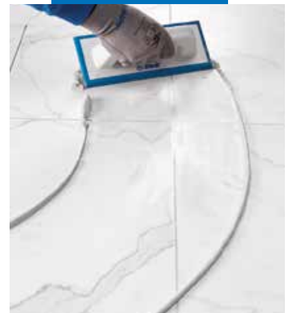
Stesura di Ultracolor Plus a pavimento con spatola di gomma su piastrelle in gres porcellanato effetto marmo
