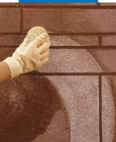
Pulizia e finiture delle fughe con spugna
