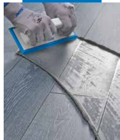
Stesura di Ultracolor Plus a pavimento con spatola di gomma su piastrelle in grès porcellanato effetto legno
