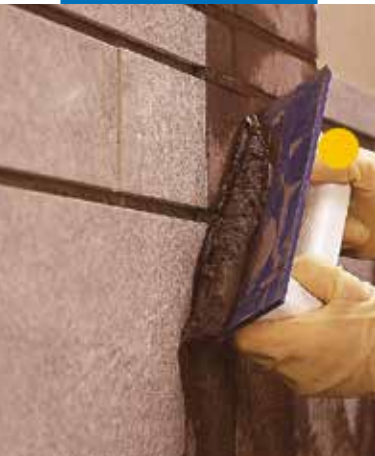
Stesura di Ultracolor Plus a parete con spatola di gomma
