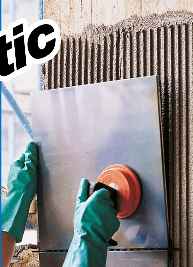
**Isolastic** è un lattice da miscelare, puro o diluito in rapporto 1:1 con acqua, con **Kerabond**, **Kerabond T**, **Kerabond Plus**, **Adesilex P10**, al fine di soddisfare i requisiti definiti dalla norma EN 12004 per le seguenti classificazioni:
